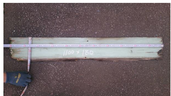
写真 2 落下した木片
